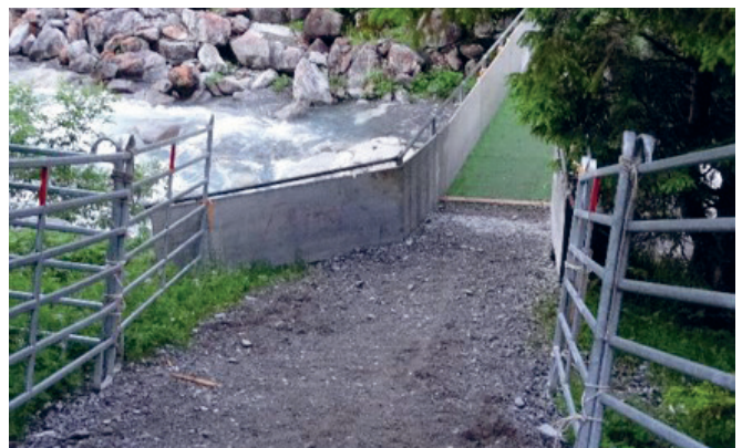
Auftriebsweg Surenen: Abstieg zur Brücke nach der Sanierung.
