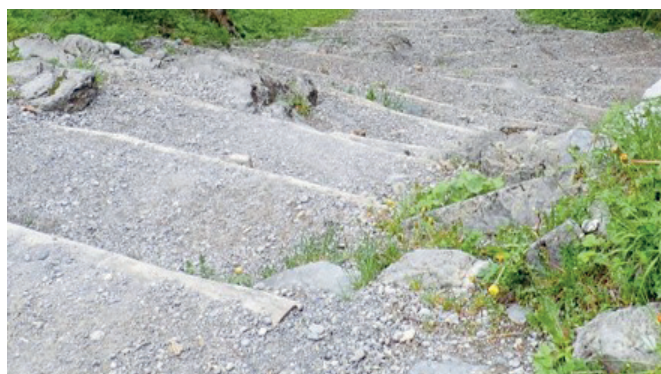
Chemin de stabulation de Surenen avant l'assainissement: l'escalier, passage très étroit, représente pour les 500 vaches qui passent ici sur une courte période, un danger élevé de blessures.
