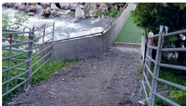
Chemin de montée de Surenen: Descente vers le pont après la rénovation de l'escalier.
