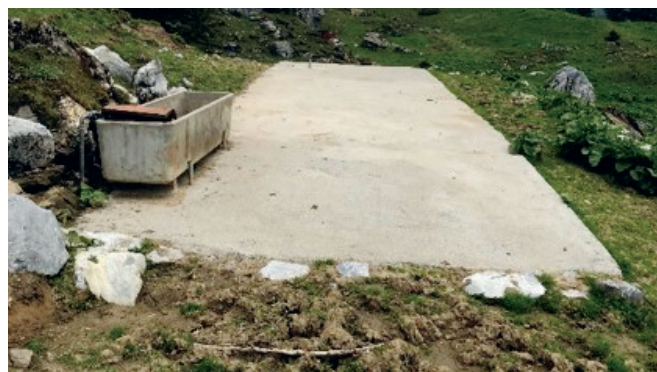
Zone d'abreuvement bétonnée et assainie.
