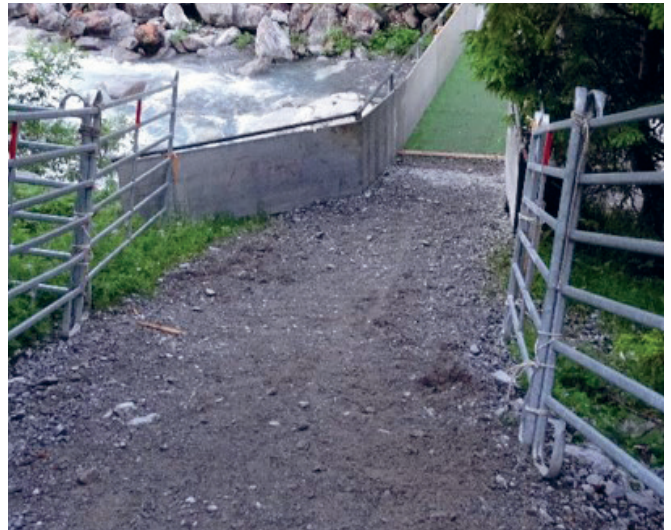
Auftriebsweg Surenen: Hirteverwaltung Surenen Abstieg zur Brücke nach der Sanierung.
