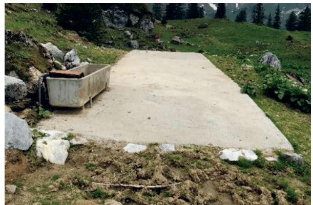
Sanierte betonierte Tränkestelle.
