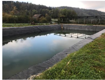
M2 Retentionsteich ohne Versickerung
